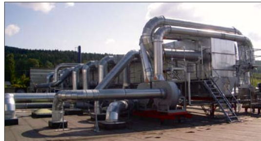
Bilde 9: Bildet viser utført enøk-tiltak på ventilasjonsaggregater plassert på tak.
