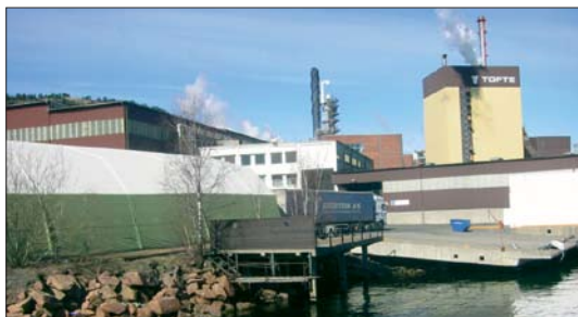
Bilde 1: Sødra Cell Tofte AS på Tofte i Buskerud er et prosjekt som har fått innvilget støtte for energioptimering i 2004.
